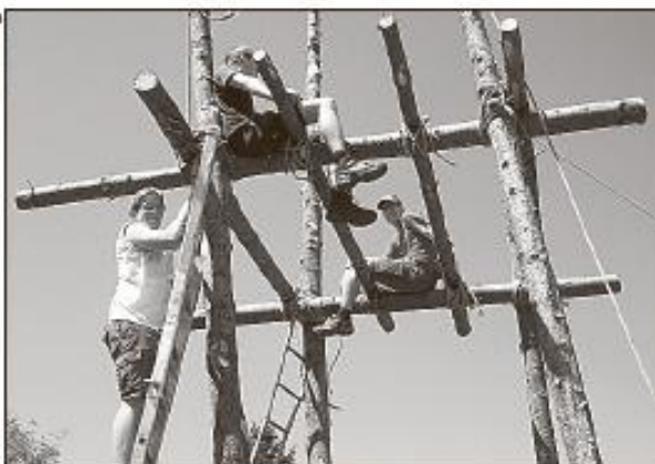
Die Pfader beim Aufbau des Lagerturms.
